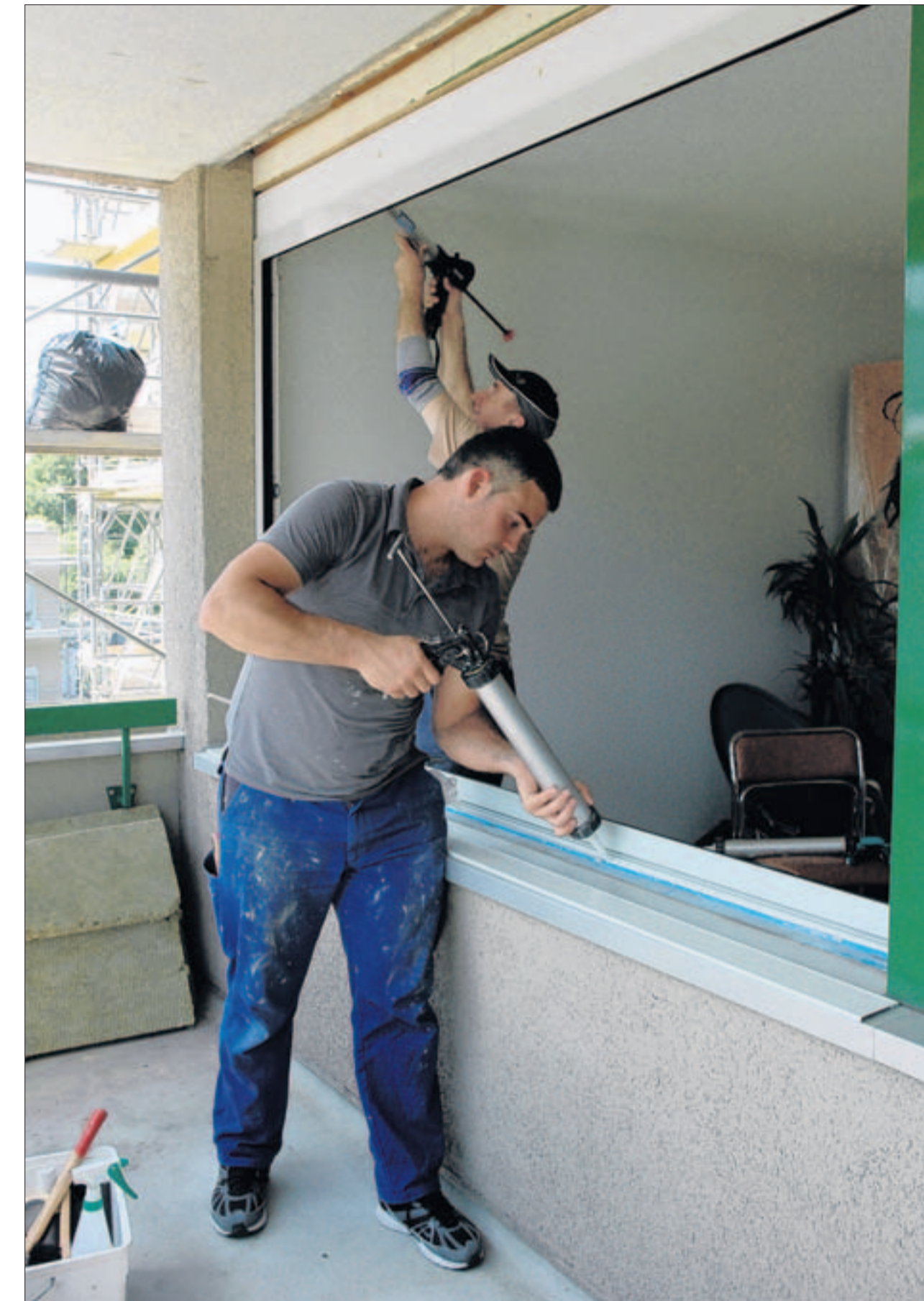
Fensterrahmen müssen mit Hilfe eines speziellen Kitts ländicht gemacht werden, bevor das Fenster eingebaut wird. In der Flughafenregion kommen Firmen zum Zuge, welche sich auf den Ein- und Ausbau von Fenstern spezialisiert haben. (ph)
